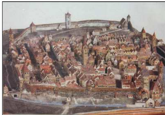
Quelle: Hinweistafel an der Stadtmauer | Aufgenommen 2017.
