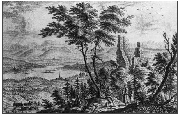
Quelle: Drack, Walter et al. - Der Üetliberg | Zürich, 1984 | S. 60
